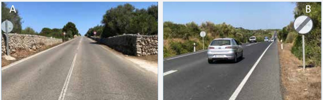
FIGURA 4. A: Secció típica de la carretera Me-12, delimitada a banda i banda per paret seca B: Secció típica de la carretera Me-1 als trams sense obres i delimitada a les zones de servidumbre per vegetació arbustiva i paret seca.
