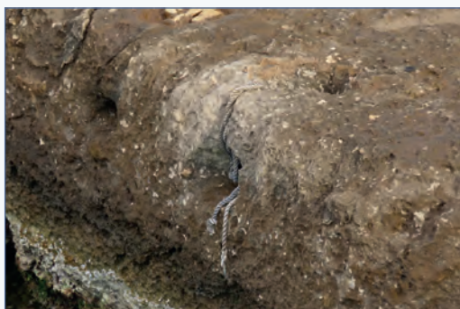
FIGURA 19. Detall dels passa cordes de Sant Felip i únic amarrador amb secció de corda longitudinal identificat a Menorca.
