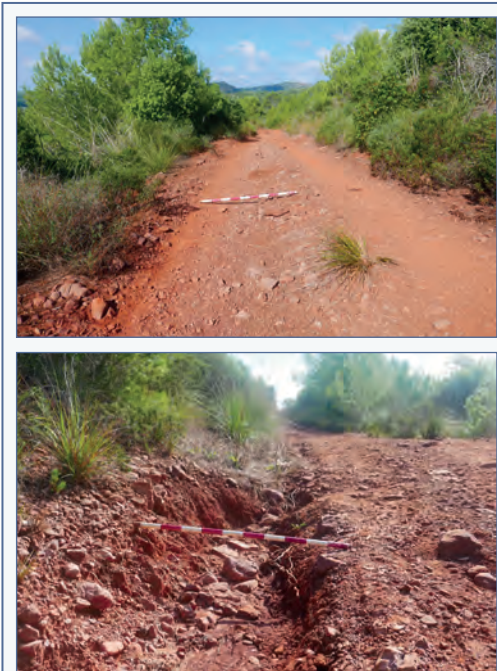
FIGURA 2. Trams del camí Reial sobre el Triàsic. Observem poca cobertura vegetal associada a la traça i sòls pobres amb presència de xaragalls.
