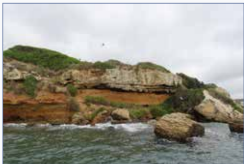
FIGURA 18. Erosió de blocs dels penya-segats a l'illa del Rei.
