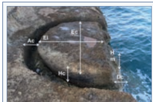
FIGURA 6. Esquema de les diferents mesures obtingudes per l'anàlisi morfològica de cadascun dels amarradors. Ec: llargada (cm), Ei: amplada (cm), Ac: secció de corda o gassa (cm), Hc: alçada de la secció de corda o gassa (cm), Hm: altura sobre nivell de la mar (m s.n.m.), Dc: distància a la costa (m).
