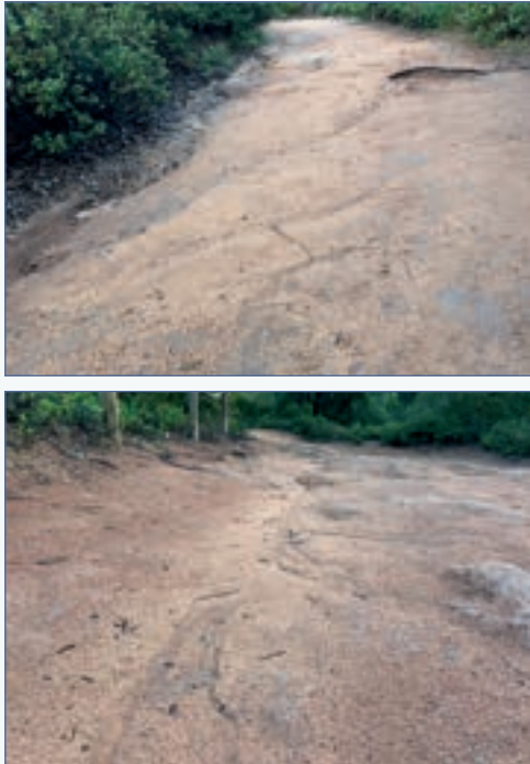
FIGURA 9. Procesos d'escorrentia laminar sobre la traça de CP a les EM 01 i 02.
